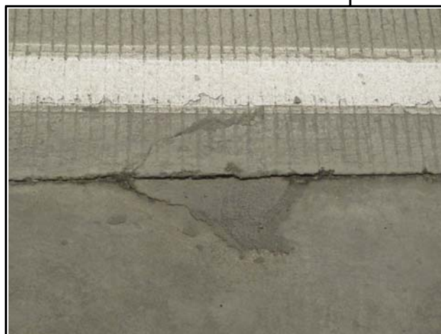
내 용 J27 바닥부 파손 보수완료
