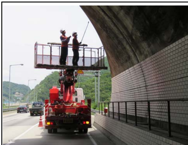
내 용 고소차를 이용한 하부구조 조사
