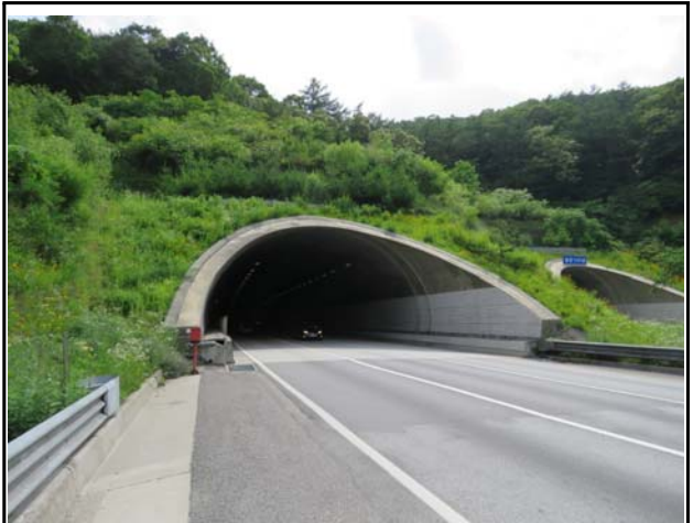
내 용 종점부 갱구부 전경
